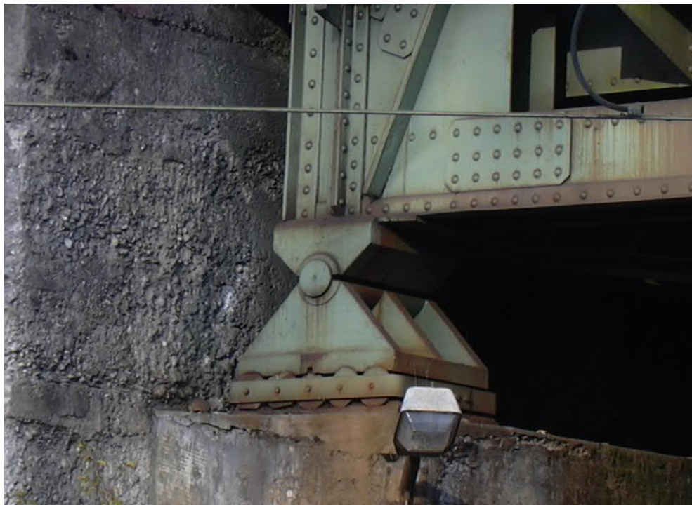
Loslager (Mehrrollenkipplager)
